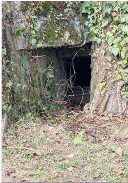
> Remise en état du Bunker
