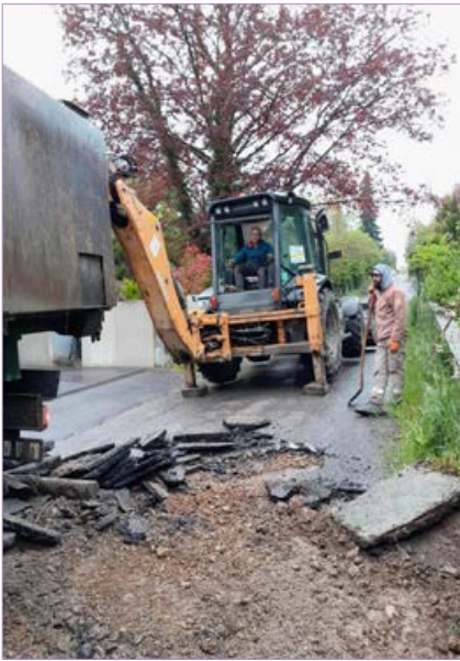
> Travaux, Chemin de la Croix
